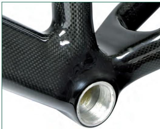
**Bild 1: Monoqoque-Rohrverbindung**
