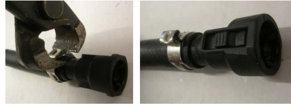
Rohradapter mit Sickenende in den Schlauch ca. 20 mm einschieben
