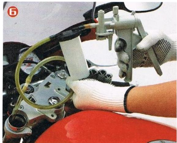
Sind beide Gabelholme entleert, verhindern Pumpbewegungen am Vorderrad, dass altes Öl im Holm verbleibt. Wer es sehr genau nimmt, kann etwas frisches Gabelöl opfern, um damit das System kräftig durchzuspülen. Auf diese Weise können Ablagerungen in der Schwebe gehalten und anschließend wieder abgesaugt werden. Wichtig: In der Regel wird der Füllstand (die Luftkammer) ohne Gabelfedern und bei vollständig eingeschobenen Tauchrohren gemessen.
